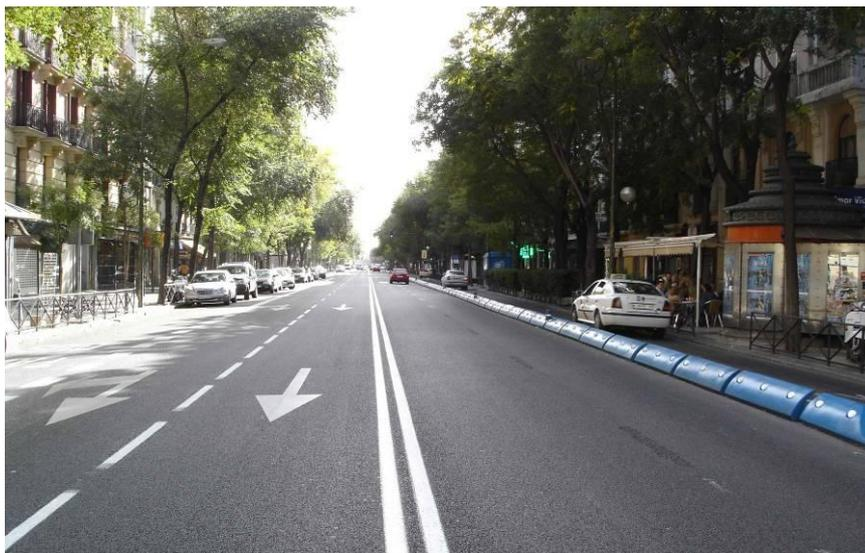
Fotografía 8. La implantación del separador del carril bus deja en ocasiones en su lado izquierdo un carril con sobrecancho que podría ser aprovechado para la implantación de un carril bici o un carril bus-bici. Ejemplo de la calle Conde Peñalver.
