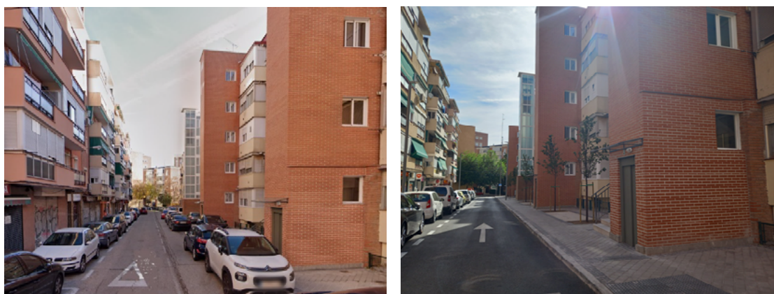
Imagen 1 y 2.- Antes y después de adecuar la sección transversal para albergar las torres de ascensor en fachada en calle Biosca.
