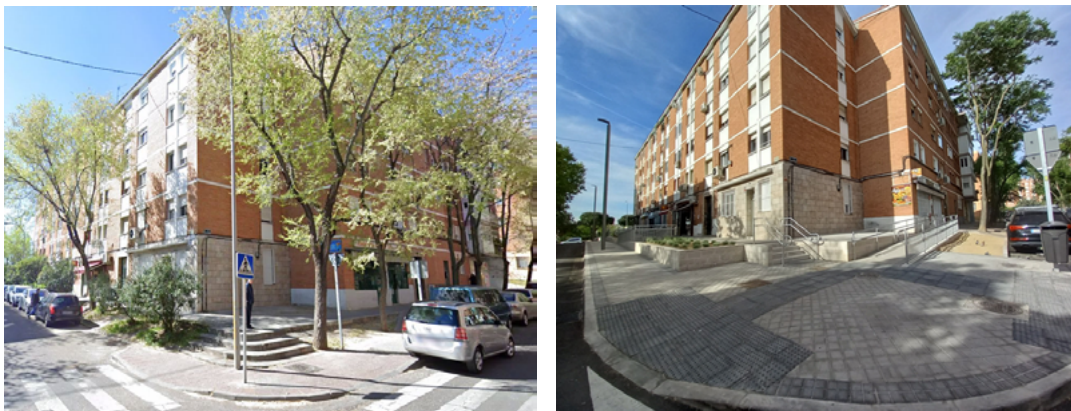
Imagen 3 y 4.- Vista de la calle Lorca en su cruce con la calle Calasparra, antes y después de la reurbanización, en una zona con desnivel entre los portales y la calzada que se salva con rampas y escaleras accesibles.
