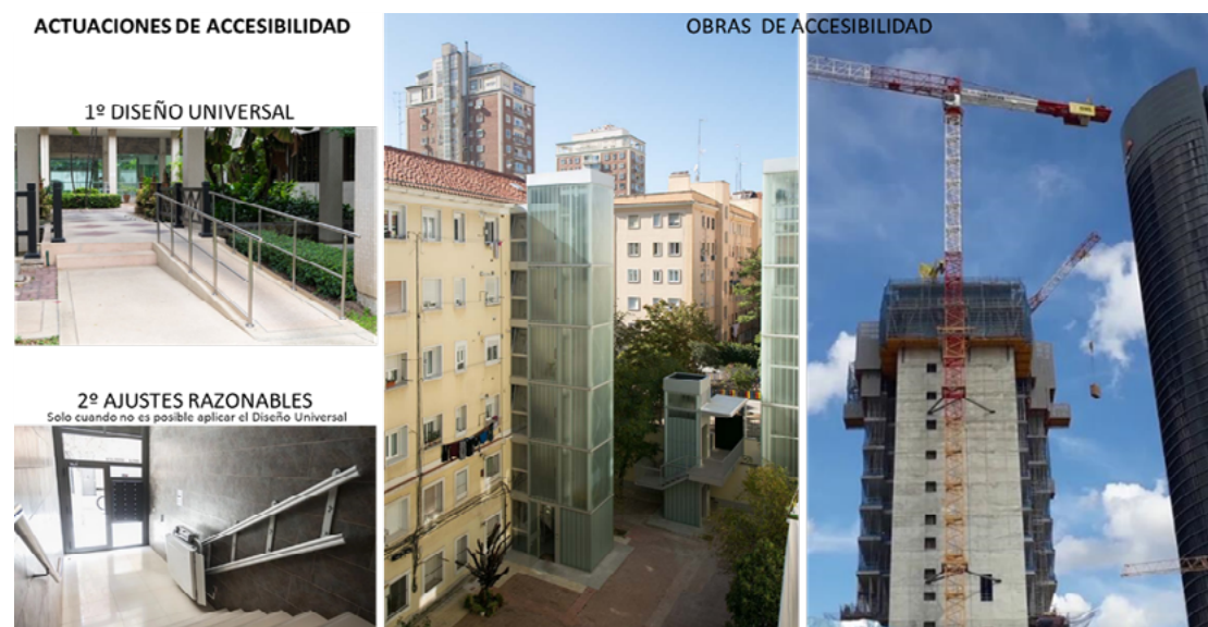
Ilustración 3. Ejemplos de actuaciones de accesibilidad y obras en los edificios
