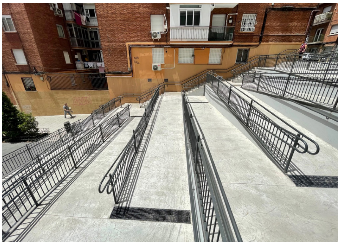
Imagen 2. Rampas en zigzag en la Avenida de los Apóstoles
