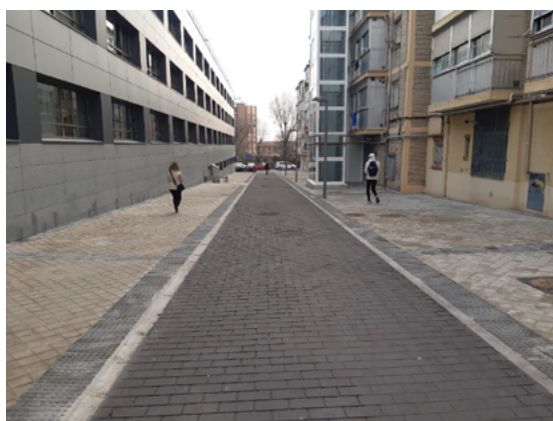
Imagen 5.- Calle Ocaña 127-137 posterior remodelada con plataforma única.
