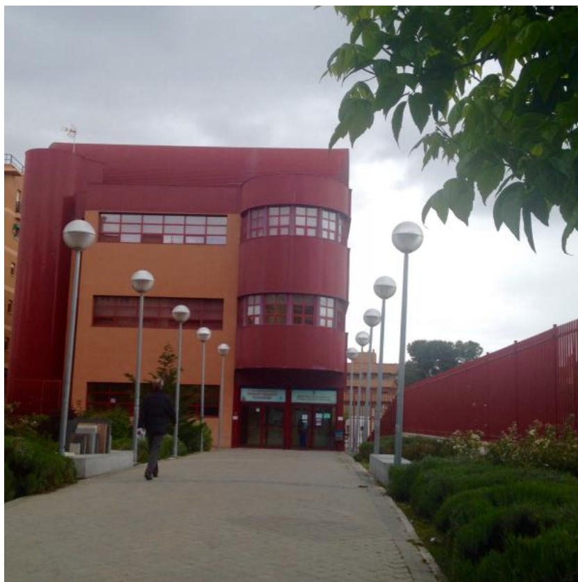
Fachada de la biblioteca
