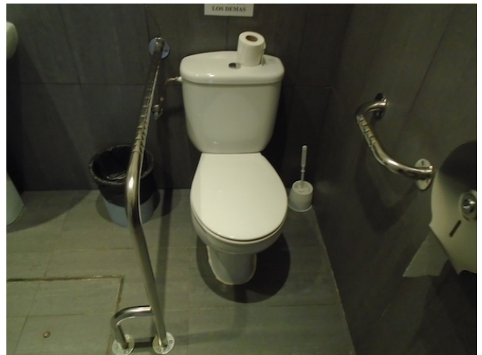
Aseo común adaptado
