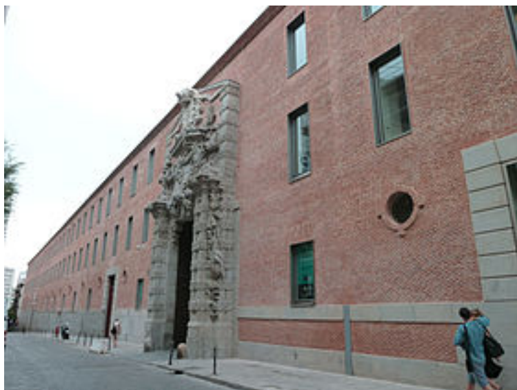
Fachada centro cultural
